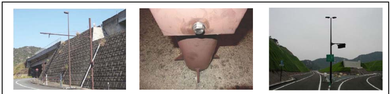
図-6 道路照明灯の現況写真
