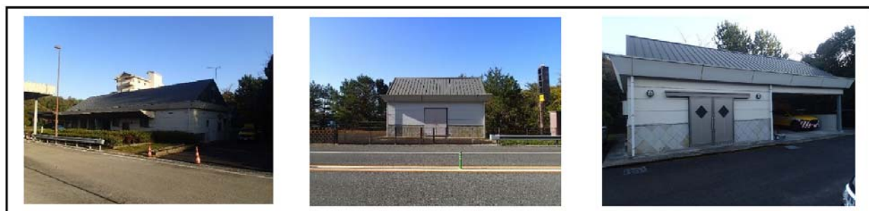
図-8 建築物全景（管理事務所棟、受変電棟、倉庫棟）
